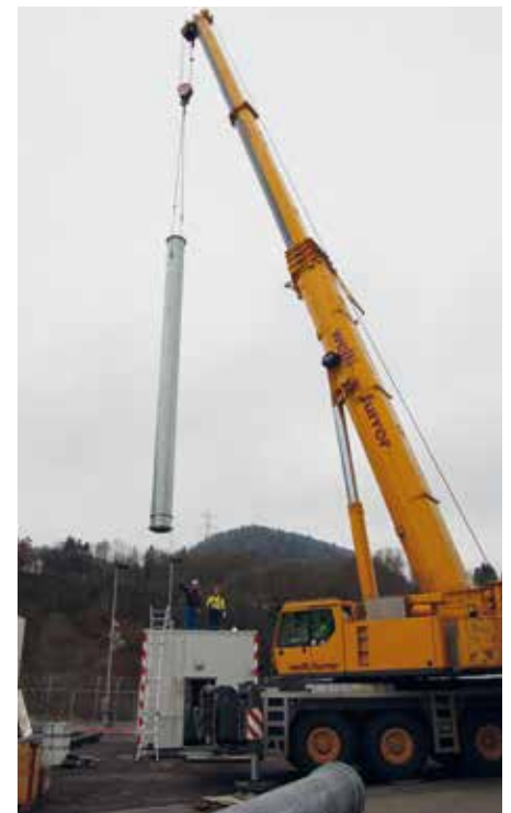
Kaminmontage auf Reserveheizcontainer
