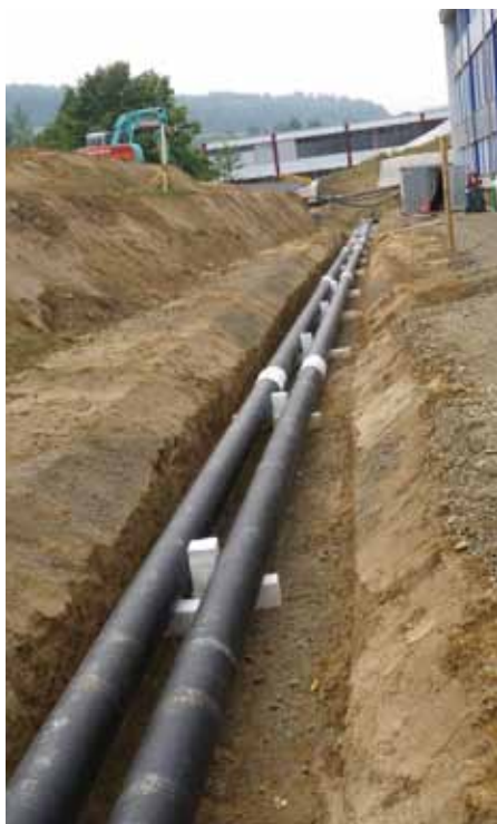
Neue Leitungsführung Schulhaus Endingen
