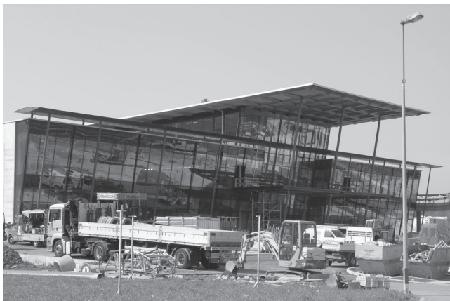
Der Coop-Aarepark in Würenlingen in der Bau-Schlussphase
